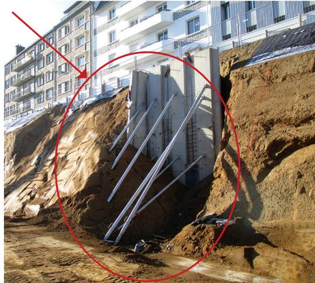
**Glissement de terrain et déstabilisation d'un voile béton préfabriqué suite au non-respect des largeurs de passes alternées**
