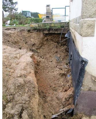
**Effondrement d'une fouille lors de l'étanchéité d'un mur de sous-sol d'une maison**
